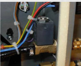
A hegesztőgép mágnesszelepe
