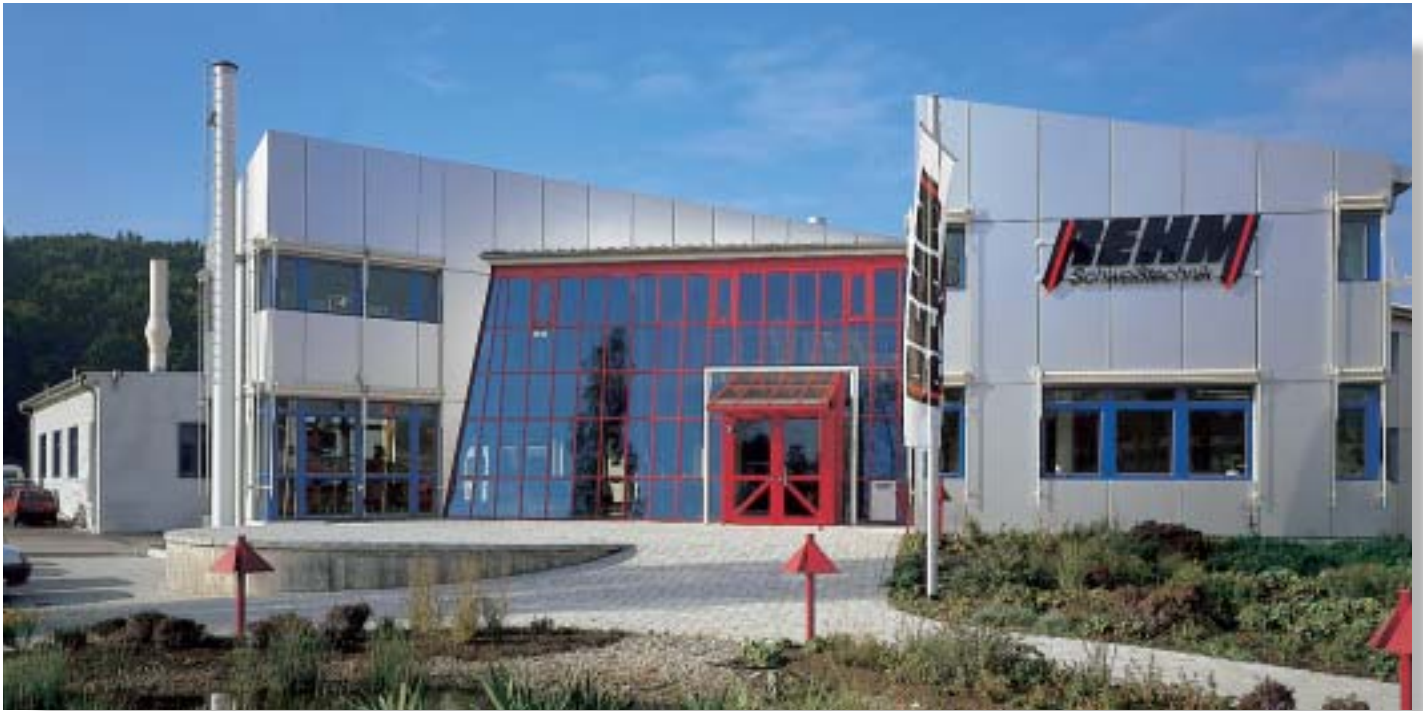
REHM Hegesztéstechnika, Udingen
